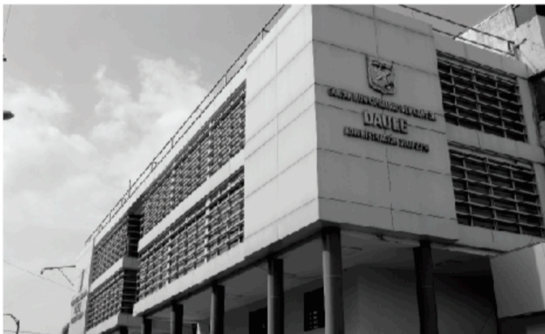
SEDE PRINCIPAL EN EL CENTRO DE LA CIUDAD
